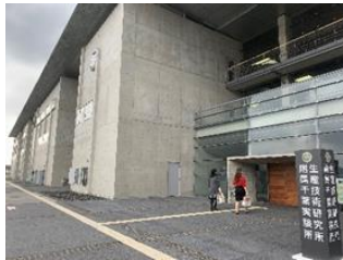
(千葉実験所研究実験棟 I 外観)
